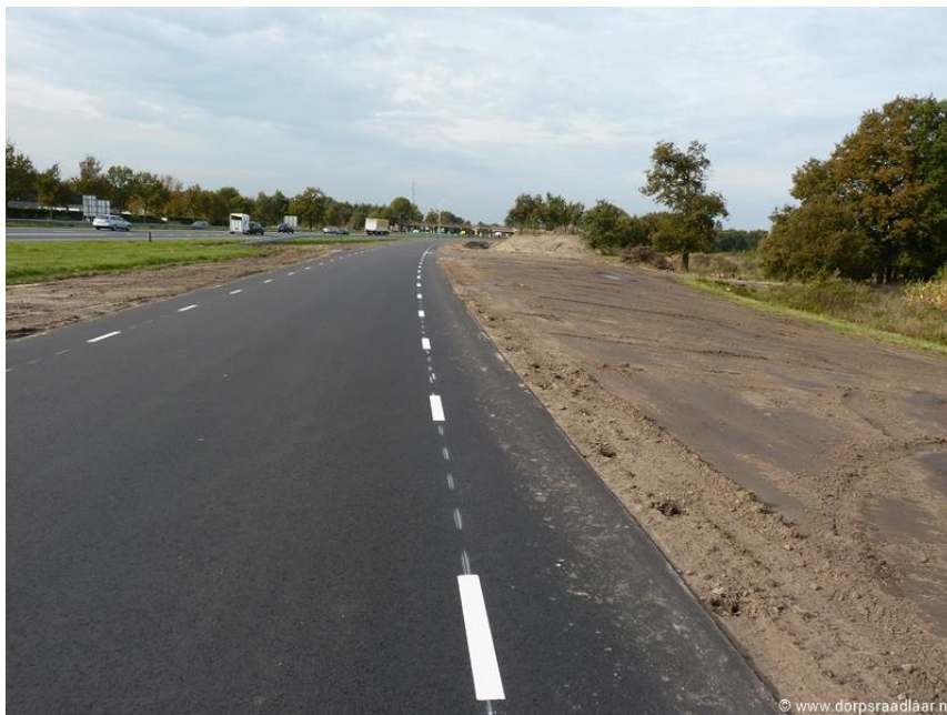
De nieuwe weg, met rechts nog het oude gedeelte.
