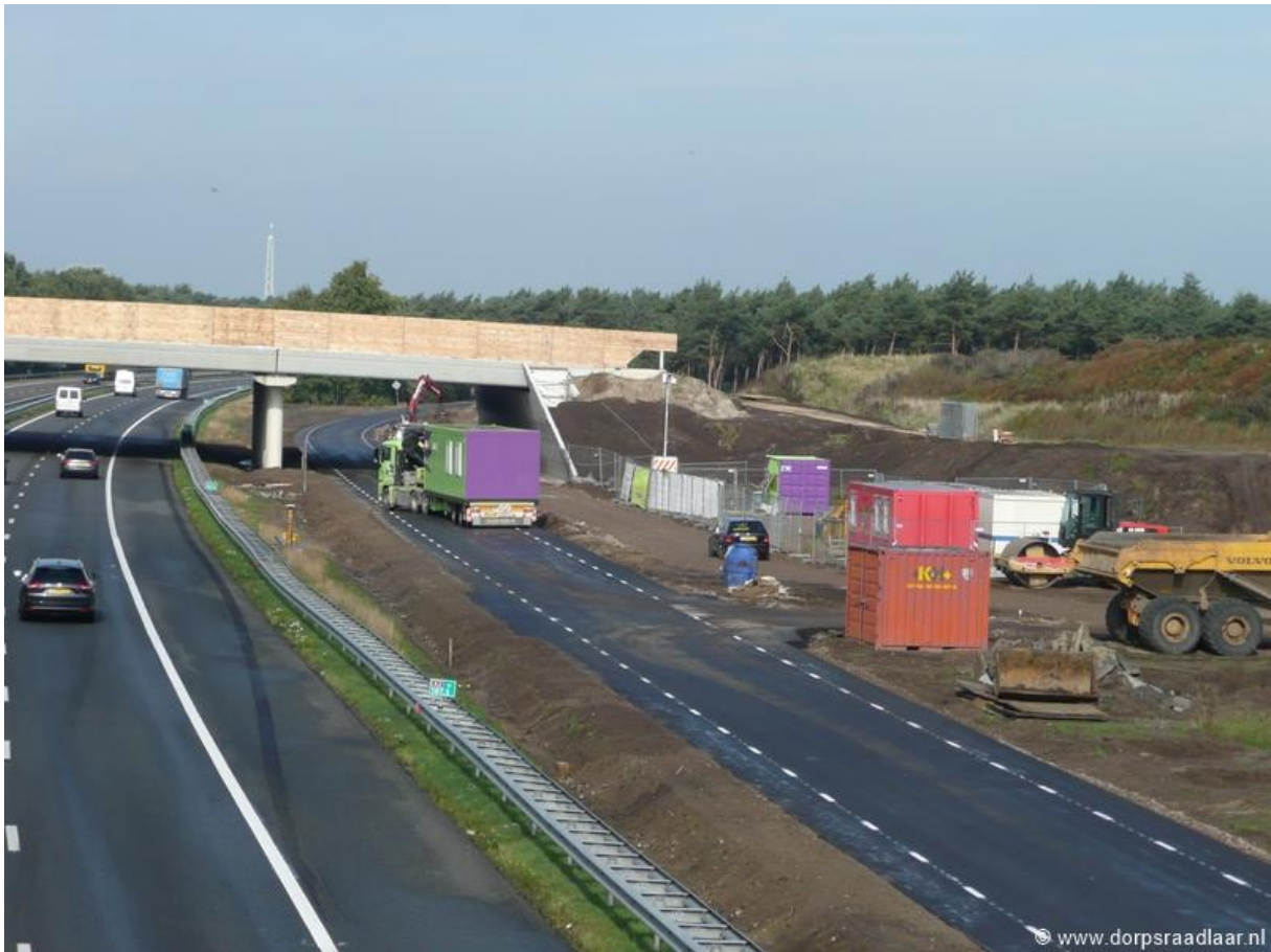
Aansluiting van de nieuwe op de oude weg langs de A2.
