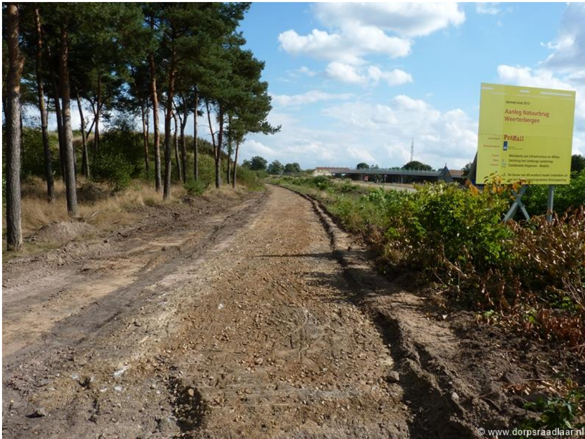
De asfalt van de Onderstalweg is al weg gehaald.
