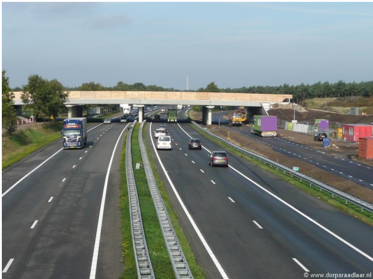
De nieuwe weg is zichtbaar.
