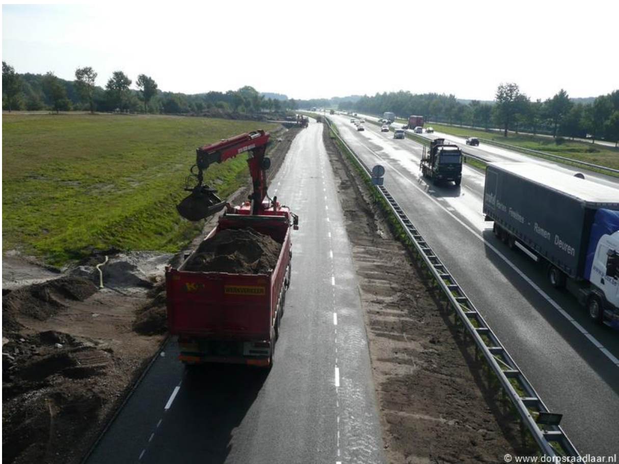
De aannemer is nog bezig met het aanvullen van de wegkanten.
